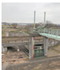
宇奈根排水樋門
